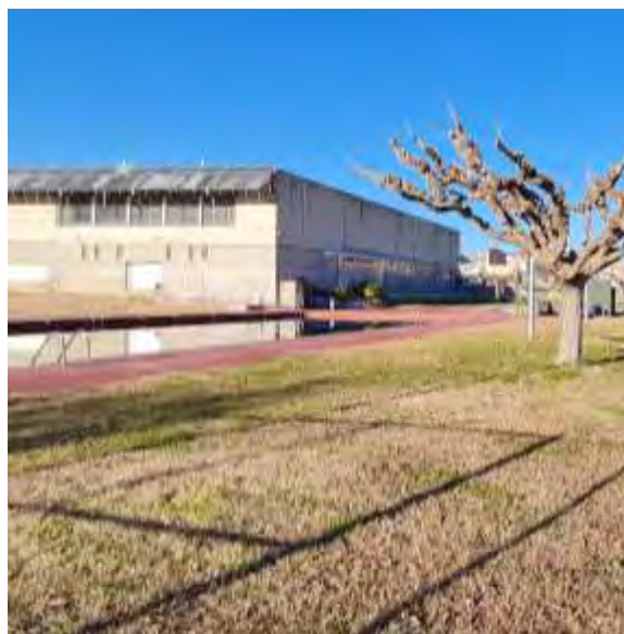
Façanes sud i est del Pavelló Foment
